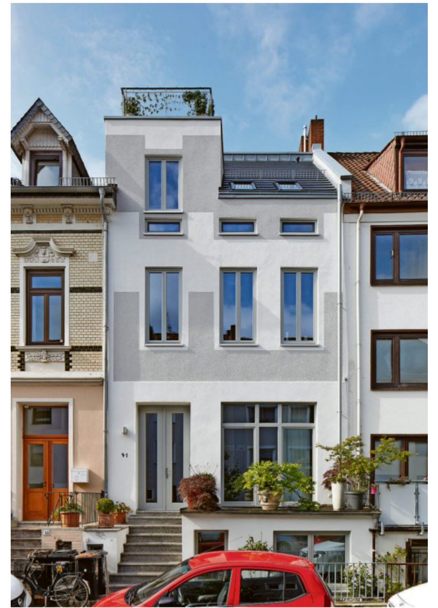
Geschlossene Lücke: Dieses Haus in Bremen hat nun wieder ein Ober- und Dachgeschoss.
